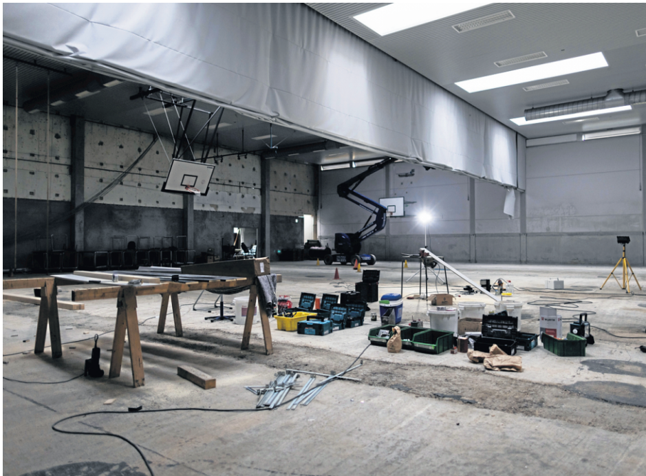
Die Dreifach-Sporthalle ist noch immer eine Baustelle. Der Boden, Teile der Wände und die Tribüne müssen erneuert werden.
